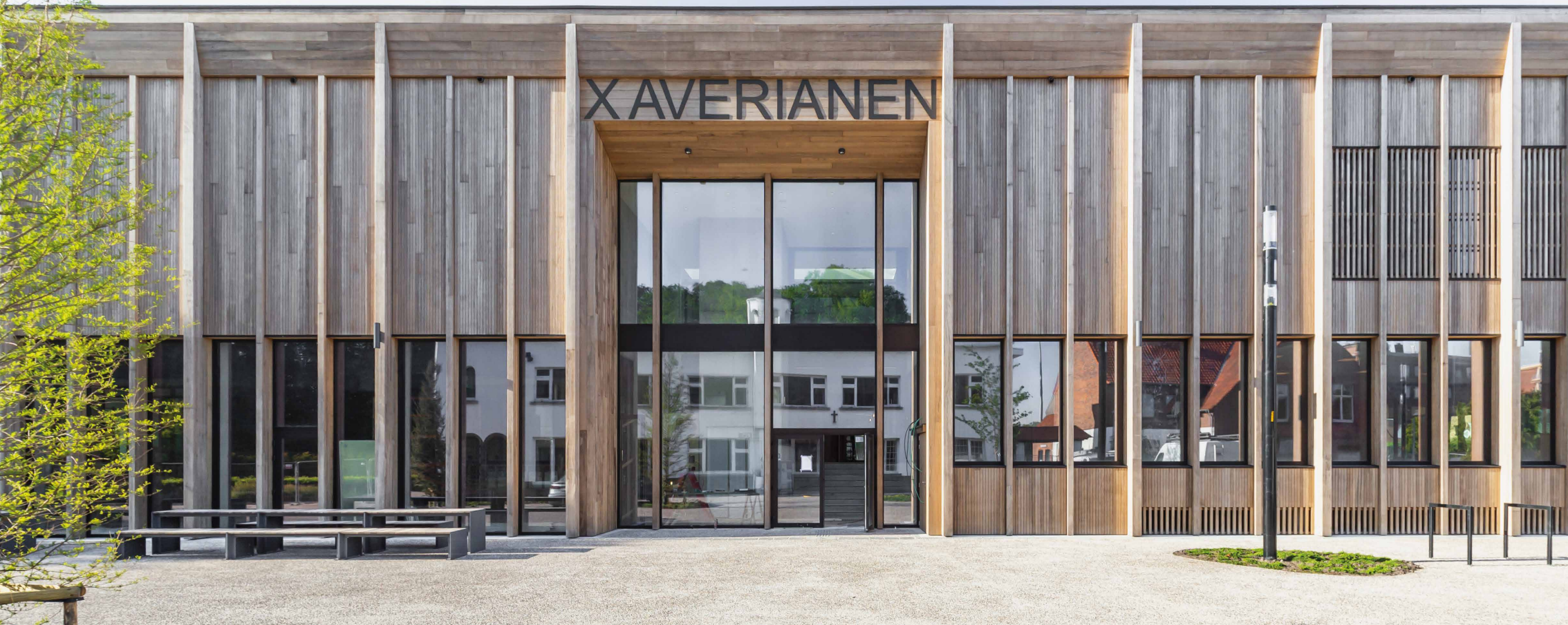
Gemeenschapscentrum Xaverianen, Brugge (BE) POLO Architects Gevelbekleding en Kolommen Platowood Fraké
